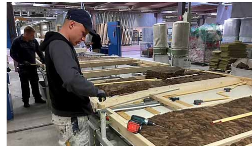
Leiding, isolatie, het wordt allemaal in de fabriek aangebracht.
