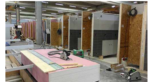
Serieproductie in de fabriek. Hier badkamers voor een ander project.
